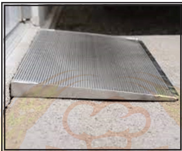
تصویر ۶-۲ استفاده از سطوح شیب دار مناسب برای برطرف کردن اختلاف سطح
