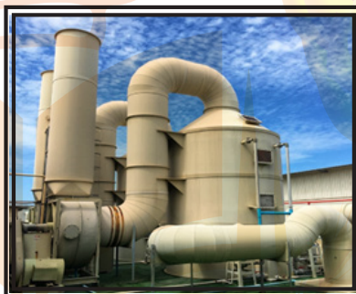
تصویر ۲-۲ نصب فیلترهای مناسب برای دستگاههای دودزای واحدهای صنعتی (انرژی انوایرو ۳ ، ۲۰۲۰)
