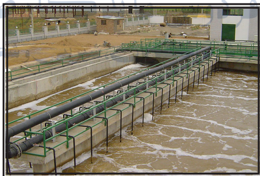
تصویر ۲-۳ نصب تصفیه خانه برای پساب های صنعتی
